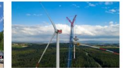
09 Die Errichtung der Windenergieanlagen beginnt.
