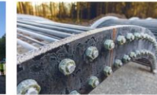
02 Das Bewehrungsgerüst wird erstellt.
