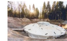
04 Die Betondecke bildet das sichere Fundament der Windkraftanlage.
