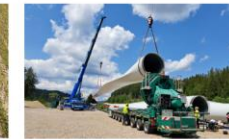
08 Auf der Kranstellfläche werden die Großkomponenten Turm, Maschinenhaus und Rotorblätter gelagert und vormontiert. Anschließend wird der Hauptkran mit Ausleger errichtet.
