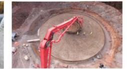
03 Beton wird eingebracht und nach Betriebsende wieder zurückgebaut.
