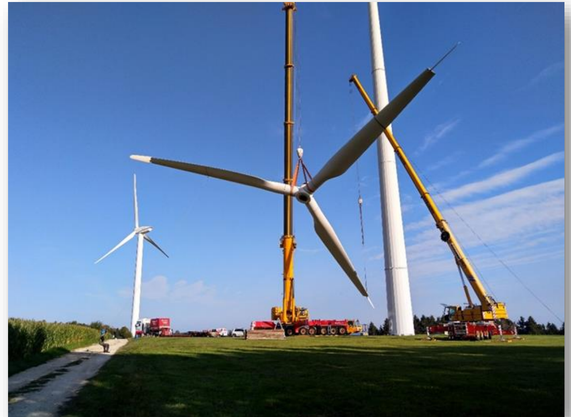
Rückbau Windpark Westerheim
