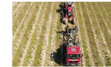
07 Die Verlegung der Kabeltrasse erfolgt, wo geologisch möglich, größtenteils mit einem gezogenen Kabelpflug.
