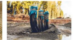
06 Bei der Verlegung der Kabeltrasse im offenen Verfahren wird ein Graben mit einer Tiefe von ca. 80 cm ausgehoben und die Leitungen in Sand eingebettet.
